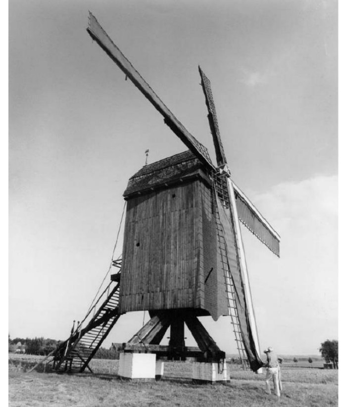
Bockwindmühle zum Mahlen von Mehl, drehbar gelagert
