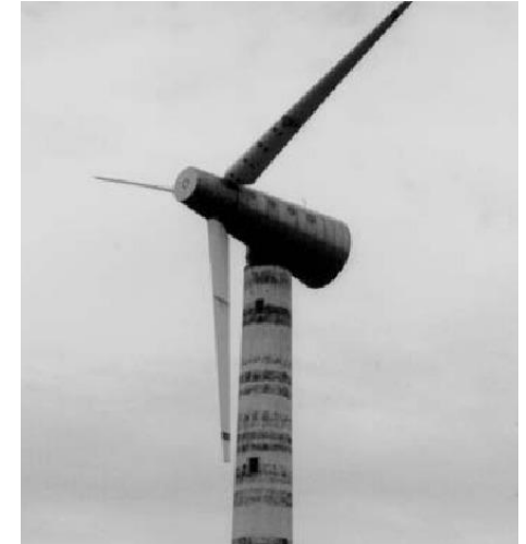
Fahnenstellung „Feathering position“
