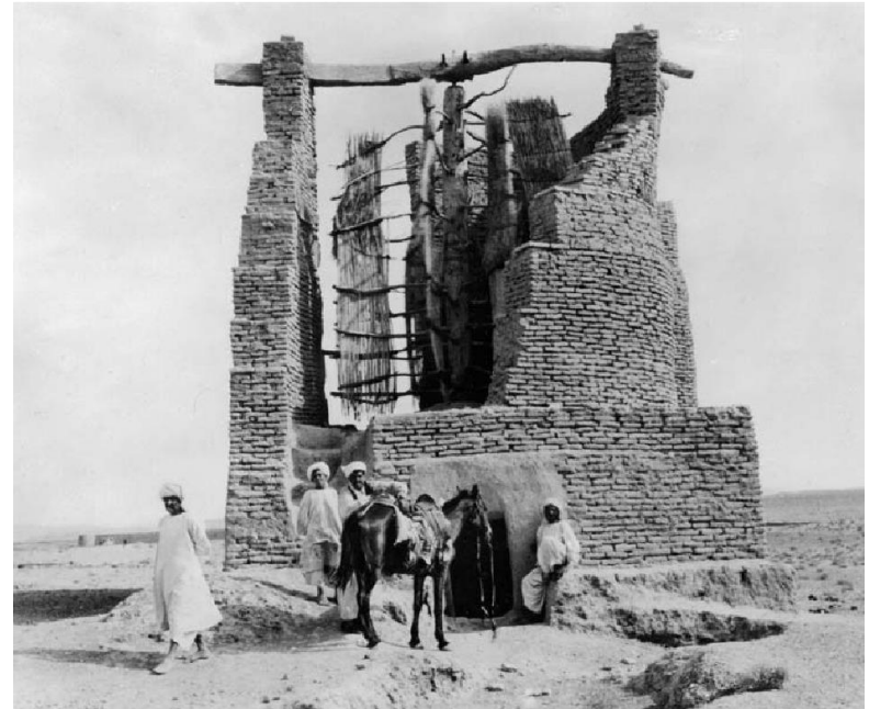
Vertikalachsen-Mühle zum Getreidemahlen aus Afghanistan
